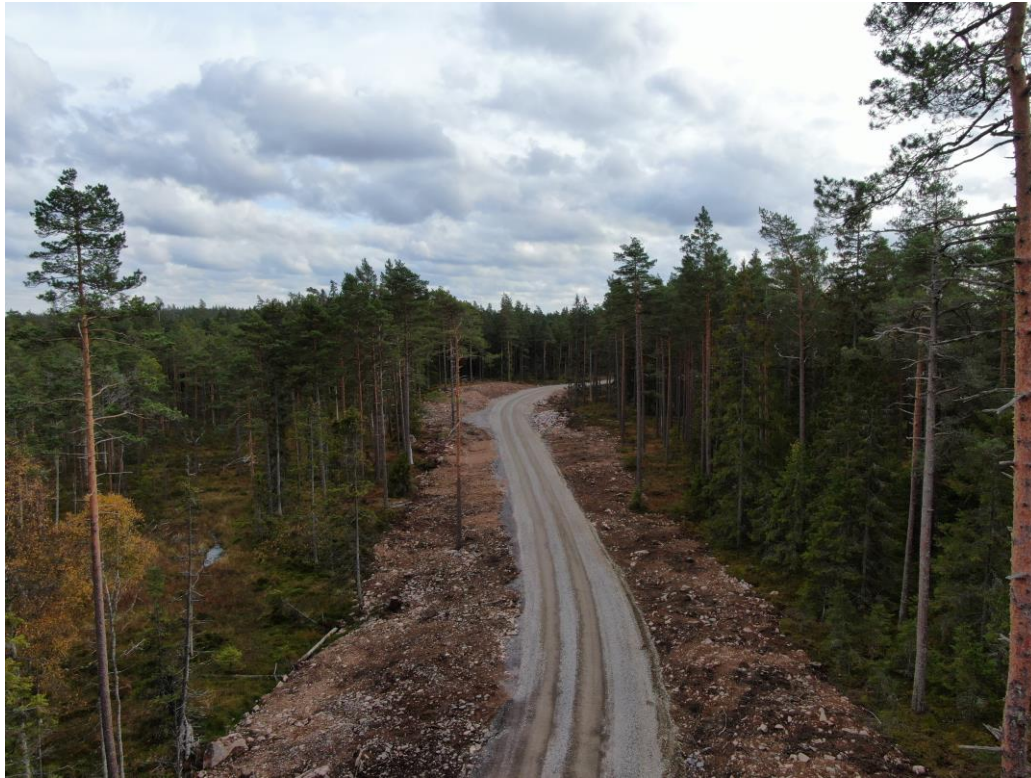
Figur 6. Exempel på nyanläggning av väg inom Karskruv vindpark (Foto: OX2)
