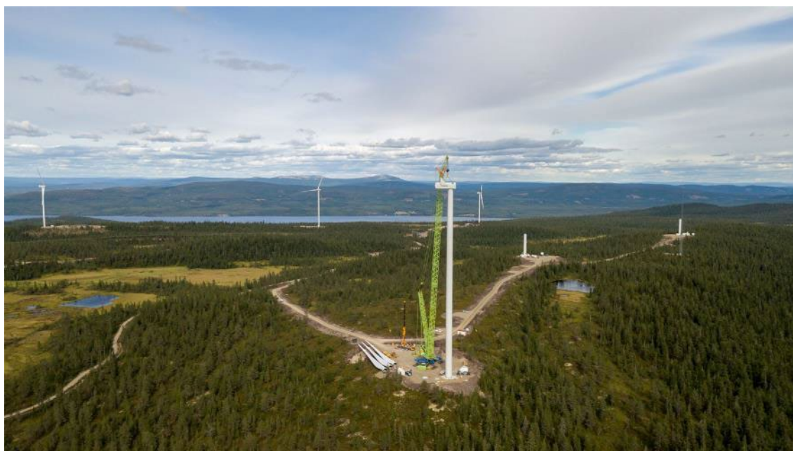
Bild från montering av ett vindkraftverk vid Raskiftet, Norge. Tornet är rest och maskinhuset har precis lyfts på plats
