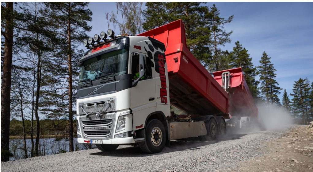
Förstärkning av vägsträcka intill Mosjön, vid byggnation av vindpark Valhalla.
