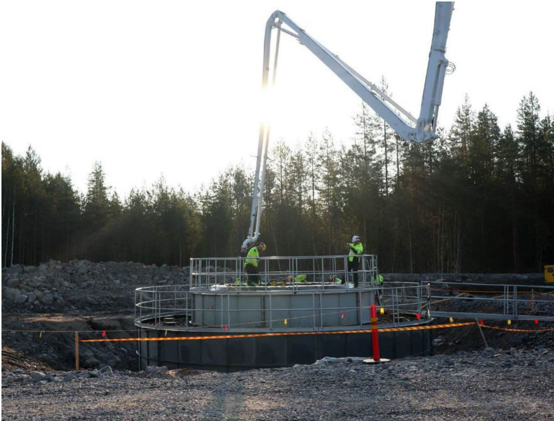
Här sker gjutning av ett bergsfundament i Metsälamminkangas vindpark i Finland.
