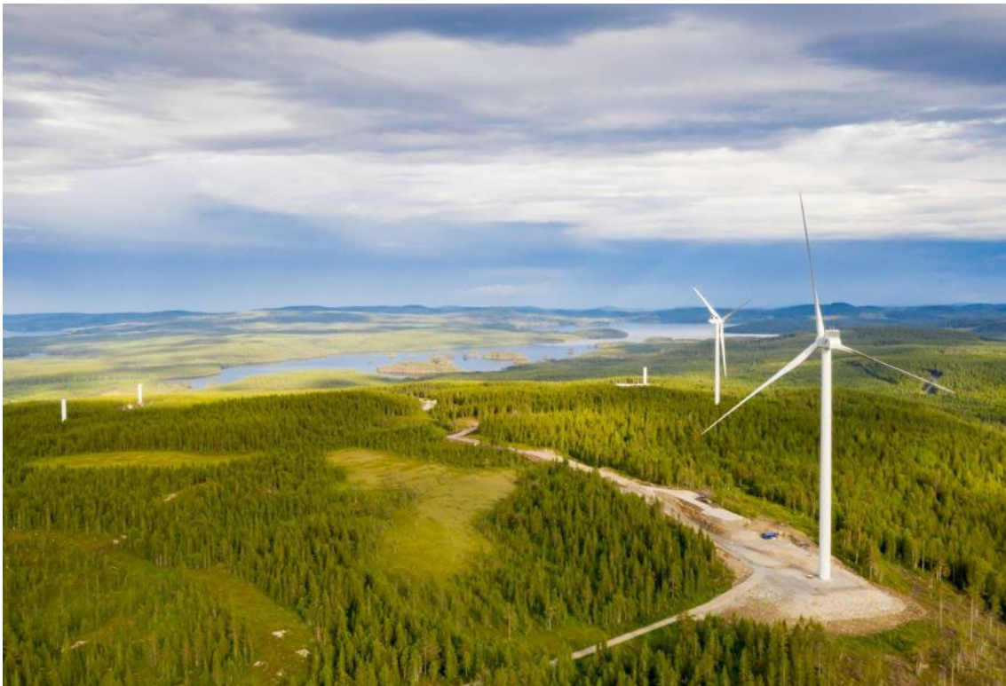
Bild från montering av vindkraftverk, Stigshöjden vindpark.
