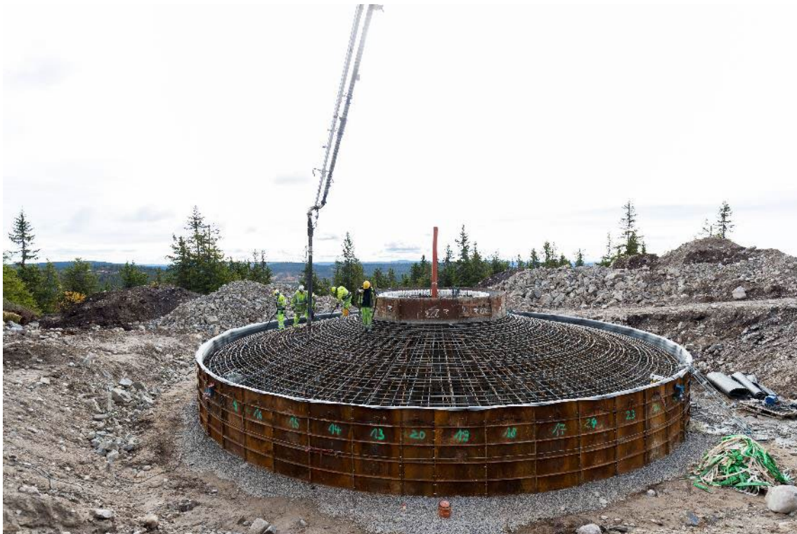
Här pågår gjutning av ett gravitationsfundament i vindpark Raskiftet i Norge.
