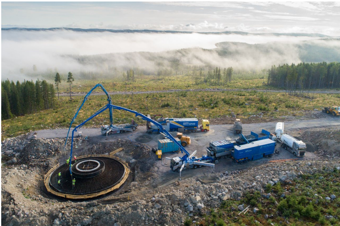
Gjutning av bergsfundament i Amot-Lingbo vindpark, Sverige. Två mobila betongstationer blandar betong direkt på montageytan.
