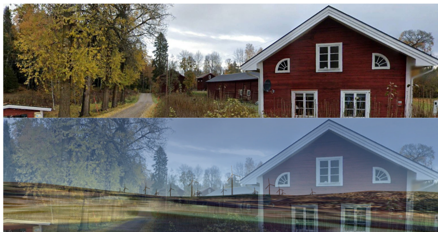
Styggjärnsberget - Hemshyttan - Eolus Vind 280 m höga vindkraftverk
